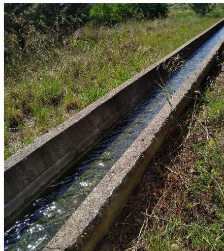
*Photo 4 : Béal en béton du réseau d'irrigation secondaire du canal de Gignac*
